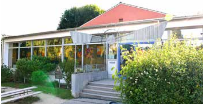
Auf der Weihnachtssitzung des Marktgemeinderats Reichertshofen wurde die Sanierung des Sonnenkindergartens Hög (Foto) einstimmig genehmigt. Foto: Vogl
